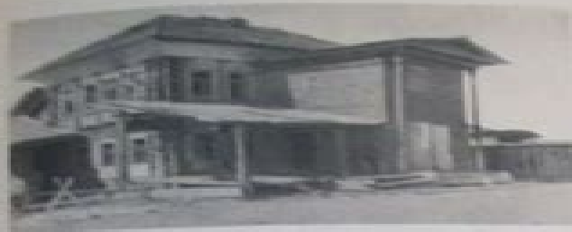
214. Вид в дачный дом в деревне Покровское, Омской области.
