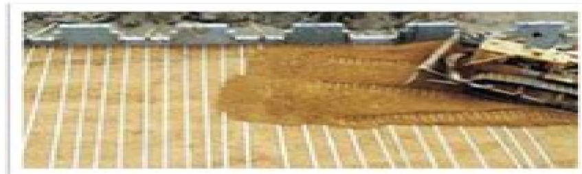
Pose des armatures longitudinales dans le remblai
