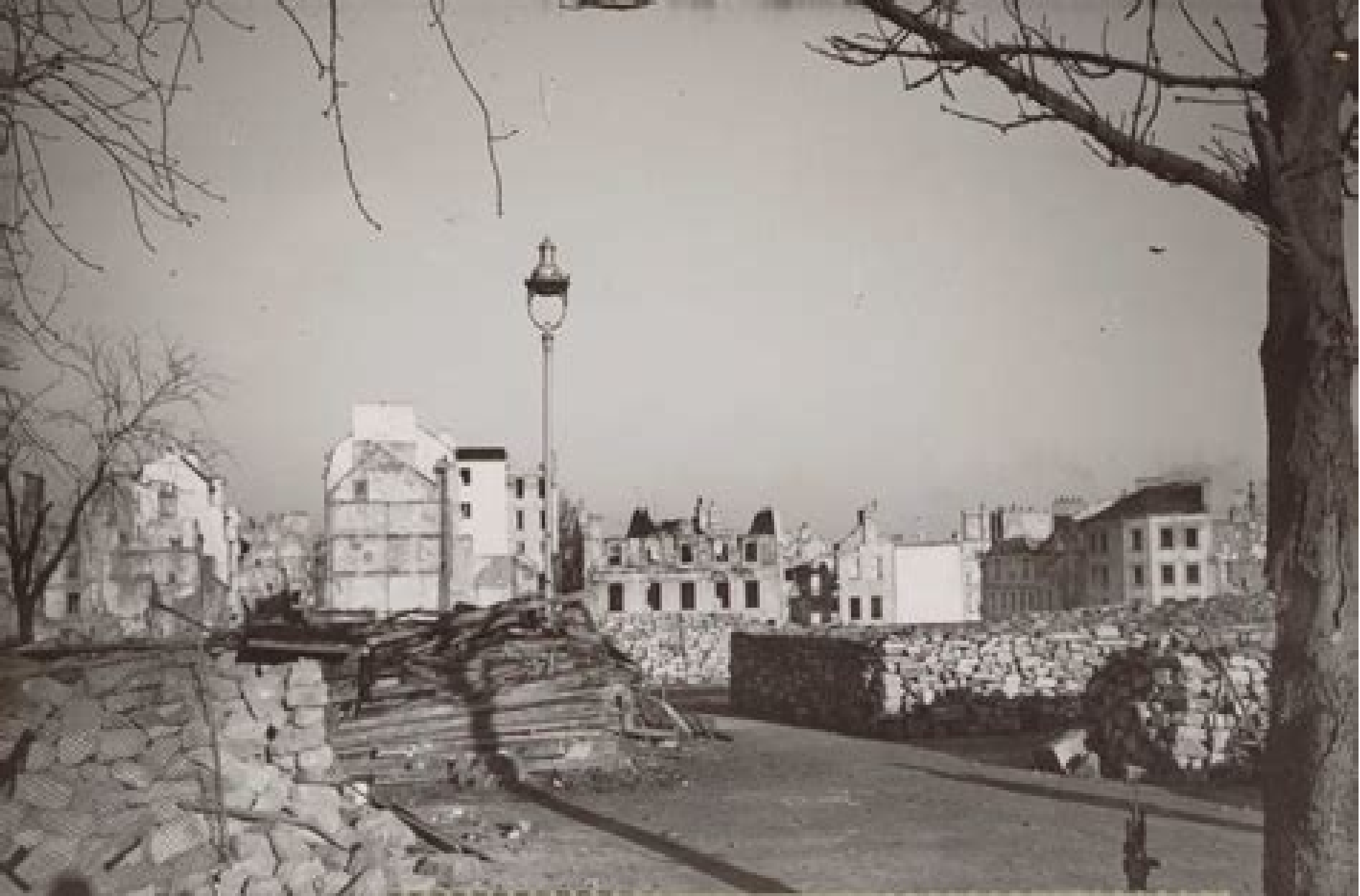
Place SAINT-LOUIS En Direction de la Rue Maréchal-Foch
